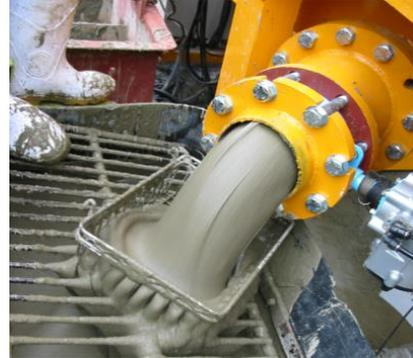
施工手順は①ロッドを所定深度まで貫入、②流動化砂を圧入、③所定長引抜き、④②③の繰り返しとなる。②では所定の改良体体積が得られる量の流動化砂を圧入する。
